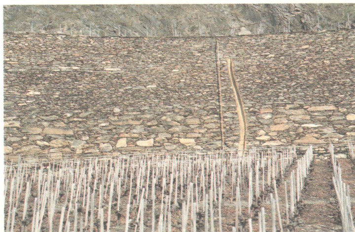
Murs en pierres sèches, Cotzette, Sion.
